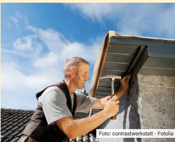
Ohne Helm und UV-Schutz in praller Sonne arbeiten.
